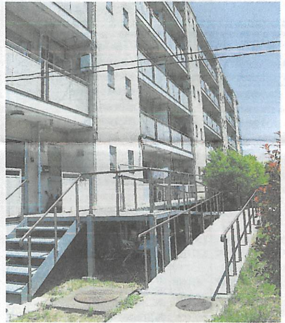
公営住宅を改修した複合施設。社会的養護の拠点になっている
